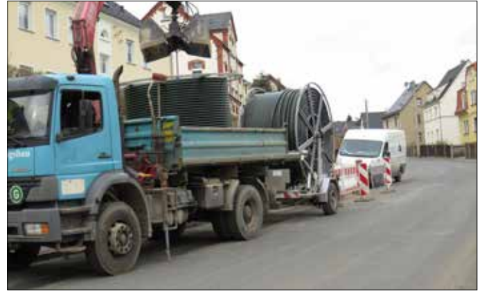
Das schnelle Internet in Mohlsdorf wächst. Mit dem Bohrgerät werden die Leerrohre in die Straßen eingezogen, die die Glasfaserkabel aufnehmen sollen.
