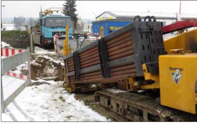
Das schnelle Internet in Mohlsdorf wächst. Mit dem Bohrgerät werden die Leerrohre in die Straßen eingezogen, die die Glasfaserkabel aufnehmen sollen.
