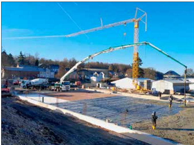
Herstellung der Bodenplatte für den neuen Markt
